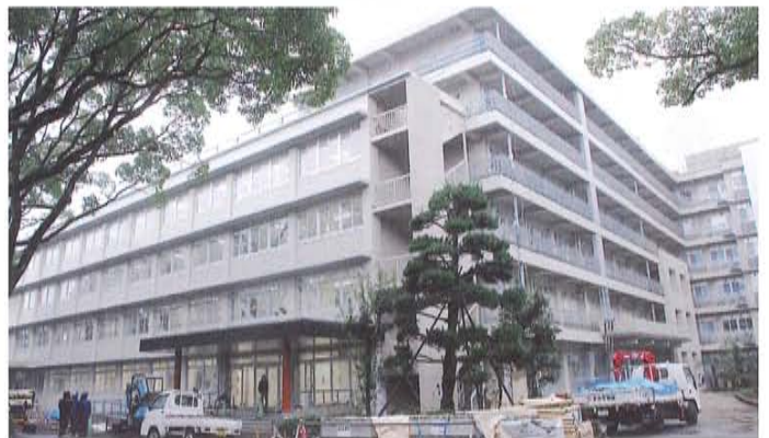
教育学部(改修工事中)
