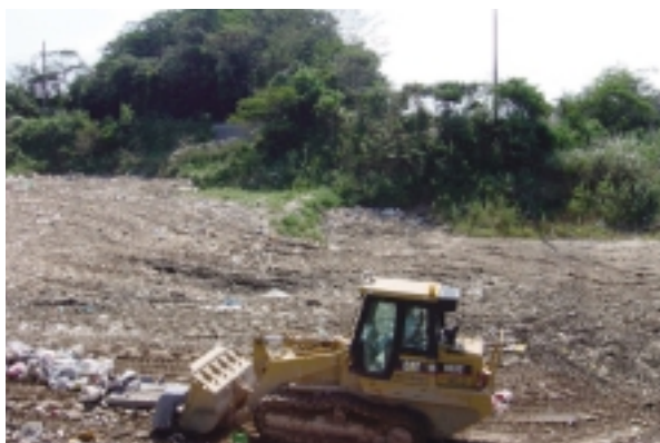
三京クリーンランド(長崎市の廃棄物最終処分場見学)
