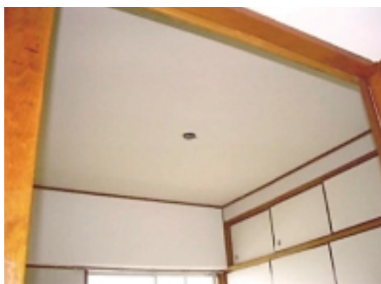
（吹き付けアスベスト撤去完了の長与職員宿舎）
