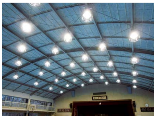
附属中学校体育館の高効率照明器具
