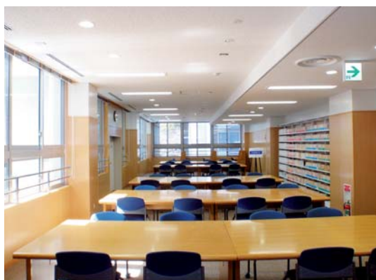
附属図書館のLED照明・LED誘導灯
