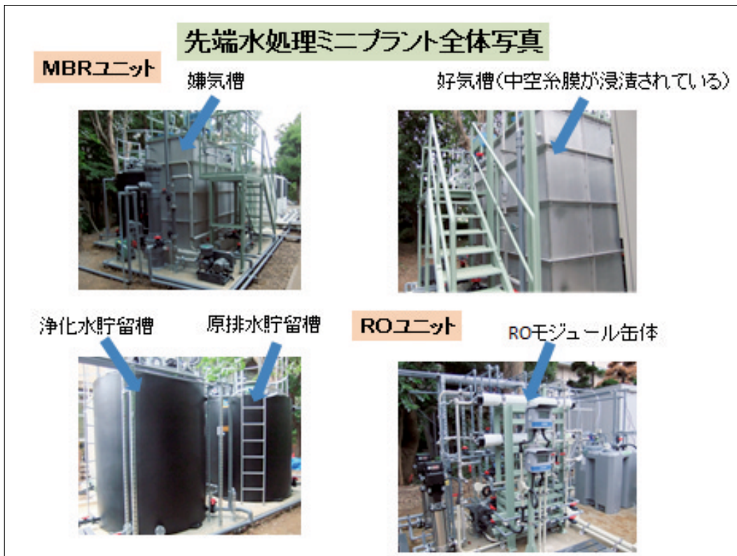
設備の各ユニットの外観
