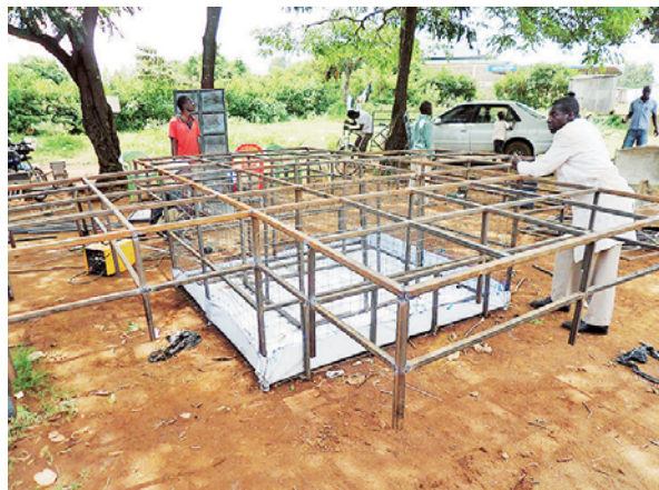
現地でのバイオフィェンス製作の様子
