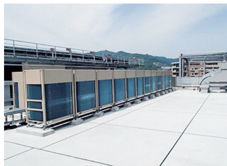
中央診療棟の空調室外機
