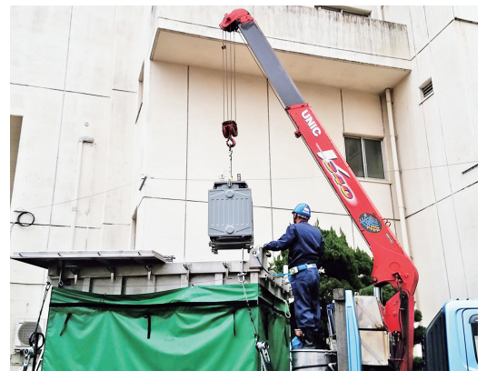
PCB含有の変圧器処分状況
