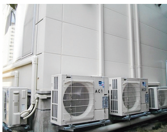
更新後（高効率空調機）
