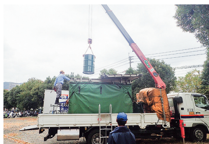
PCB 廃棄物運搬前の積込作業
