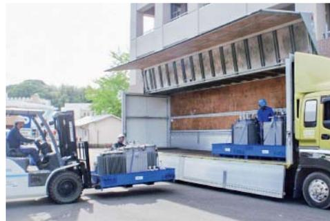
低濃度 PCB 含有の変圧器の搬出状況
