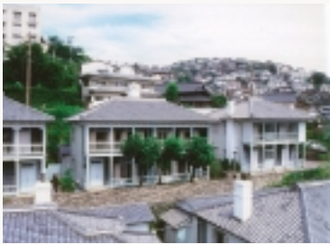
東山手7棟洋館 2)
