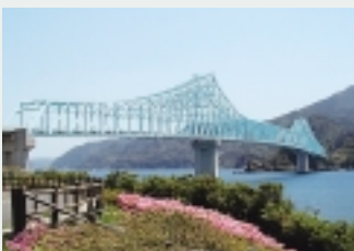
観光資源が点在する半島や離島をつなぐ橋が多い長崎県(生月大橋)
