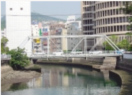
出島橋(土木学会選奨土木遺産)
