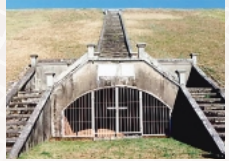
本河内高部ダム
