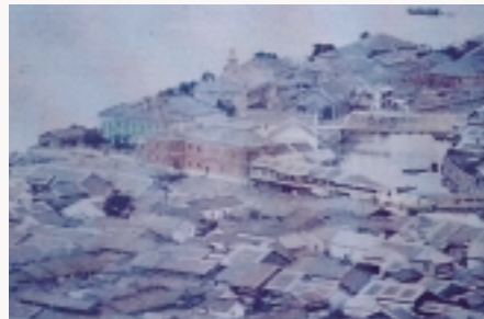
中島川変流工事直後(1889年頃) (長崎大学附属図書館所蔵)
