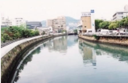
中島川の出島付近(中島川変流工事)
