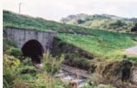
大草駅・本川内駅間の盛土と山川内袴川橋 (1898年(明治31)建設)
