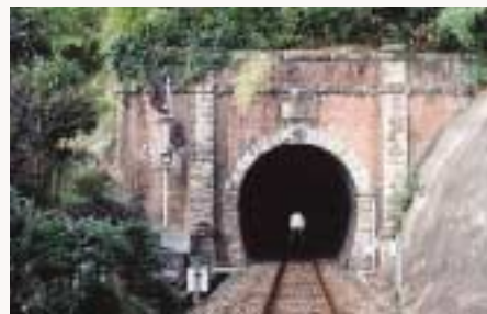
南風崎隧道(1897年(明治30)建設)
