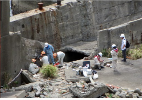
長崎大学原田研究室と早稲田大学や建設会社のグループと共同でコンクリートの調査をしているようす。
