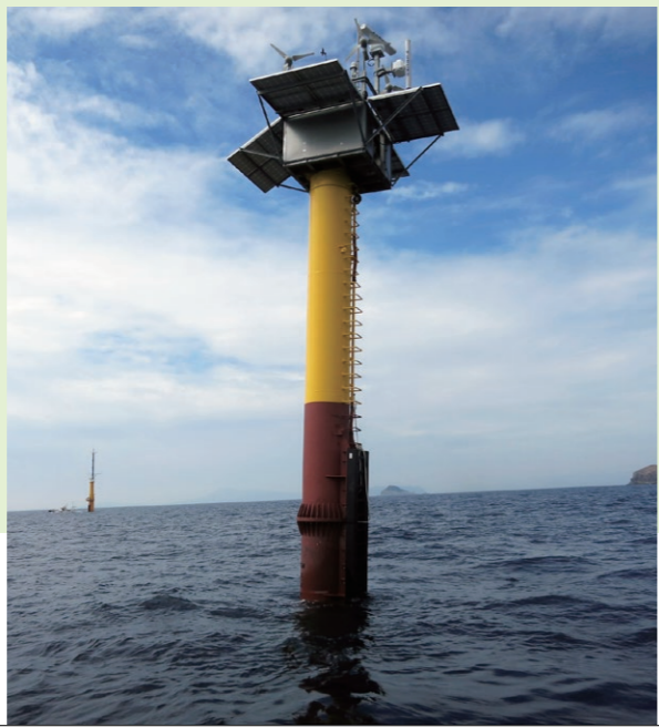
五島沖に設置した海洋統合環境無人観測プラットフォーム。洋上風力発電に必要な情報が取得できるこの機器の電源部分が協和機電の担当で、末吉さんは組込配線工事などを行いました。
