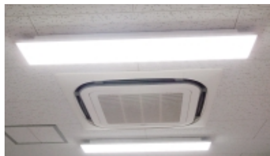
LED 照明器具を設置した事務室（改修後）
