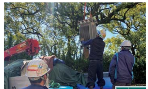
低濃度 PCB 含有変圧器の搬出状況
