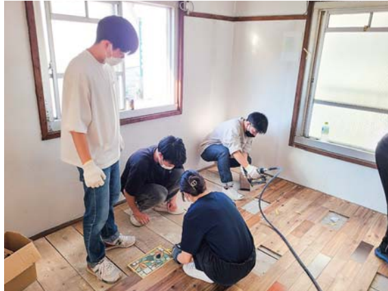
旧県営魚の町団地での古材や古タイルを利用した床の改修
