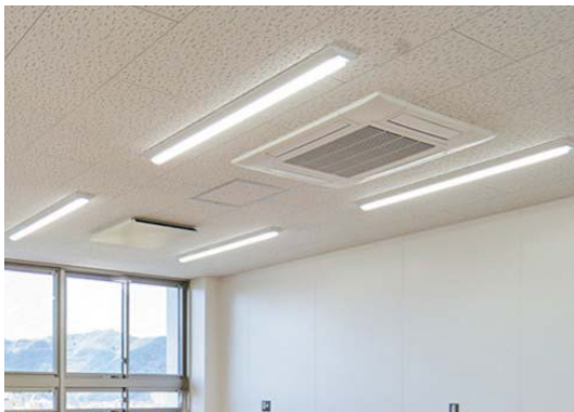
LED照明器具、高効率空調機、全熱交換機の設置状況
