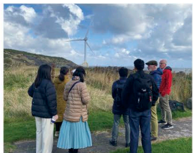
洋上風力発電設備での研修風景(スコットランド リーベンマウス) ※「ながさきBLUEエコノミー」と「潮流発電」は、JST共創の場形成支援プログラムの支援を受けたものです。
