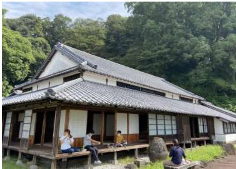
イートインスペースとして活用する湯太夫邸縁側
