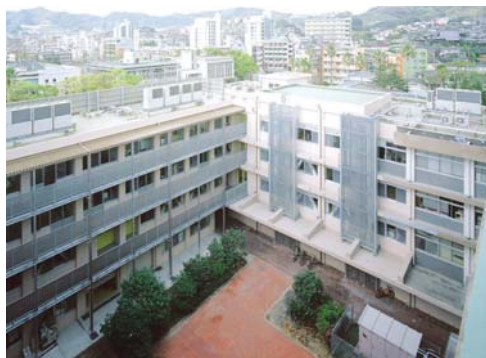
4 工学部校舎の改修工事 2007年3月撮影(長崎大学施設部提供) 校舎の改修部分には建物内に鉄骨ブレース(斜材)による耐震補強がなされています。
