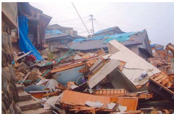
5 玄界島斜面の被災建物 2005年5月7日撮影(高橋和雄撮影) 福岡県西方沖地震で玄界島の斜面の住宅の8割が全半壊しましたが、日頃の備え、近隣の協力によって、死者はありませんでした。また、火災の発生もありませんでした。
