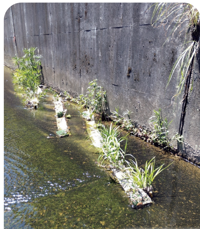
バープ工をメッシュ状の素材に切り替えた状態。事前に植生を施すことで土砂の流出を防ぎ、植物の生長を促します。
