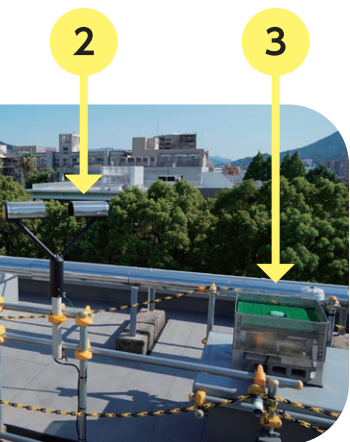
工学部1号館屋上に設置されている降雨観測機器。①は上空に雨粒があると電波が反射されるマイクロレーダー。②はセンサーの上に落ちた雨粒を計測するディストロメータ。2年前、新たに雨粒の大きさを測る装置③が追加されました。常時これらの機器から、データが送られてくるシステムです。
