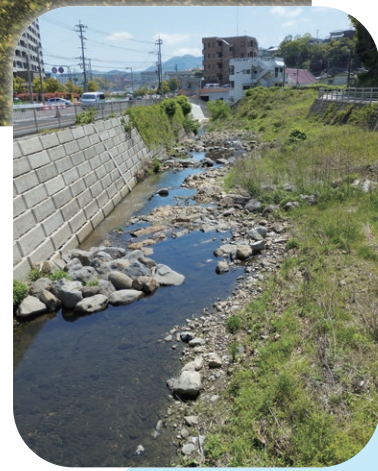
滑石付近では、もともと三面張りコンクリートだった河川が再生されています。
