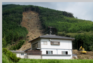
豪雨に起因した斜面災害
