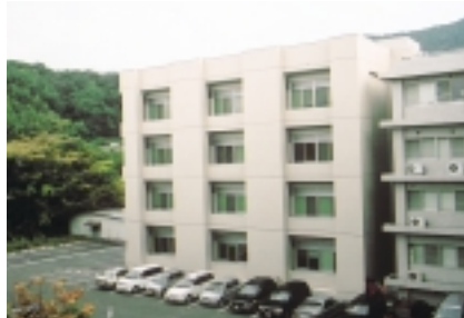
熱帯医学研究実験棟。この研究所では国内の共同利用研究の他、WHO、外務省、JICAなどの要請による熱帯現地での研究・技術協力・海外の大学や研究機関との学術協定による共同研究を行っている。COEにおける国際的な研究拠点施設として、さらなる研究の高度化・国際化を推進している。
