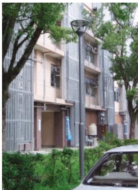
省エネランプの外灯
