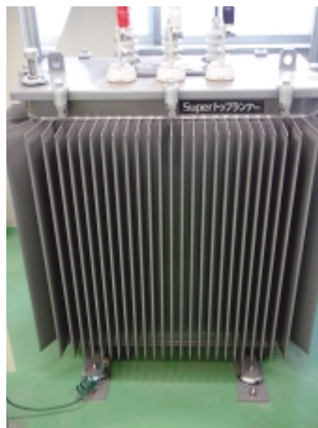
高効率変圧器
