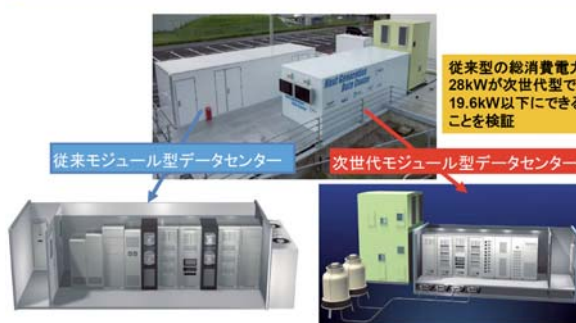
従来型モジュールセンターと新開発のモジュールの性能比較試験設備
