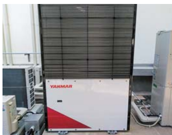
更新後 (高効率空調機)
