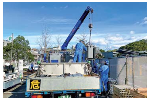
低濃度 PCB 含有変圧器の搬出状況
