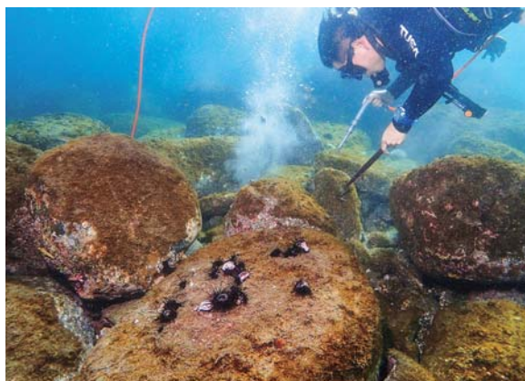
潜水作業中の様子
