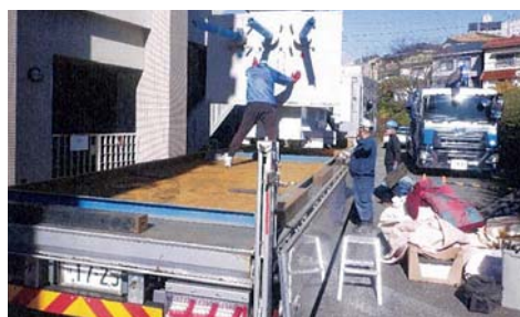
低濃度 PCB 含有変圧器の搬出状況
