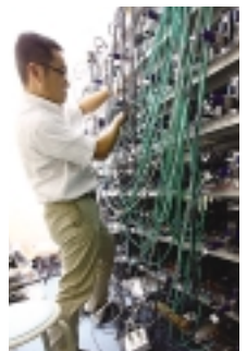
トラブル対策の部品交換が頻繁に行われる。「腰をかがめてやるきつい作業が続くので、体力が必要です。」
