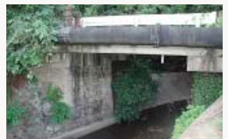
四反田橋橋台 (1920年(大正9)頃建設、旧佐世保鉄道・廃線)
