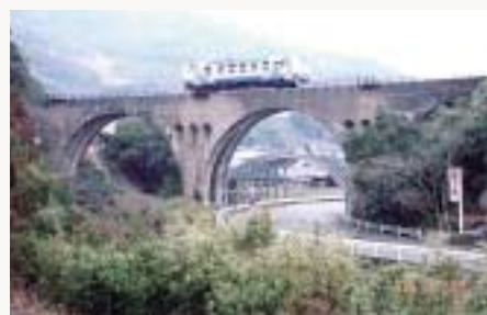
福井川橋梁 (1939年(昭和14)建設、旧国鉄伊佐線・現松浦鉄道)
