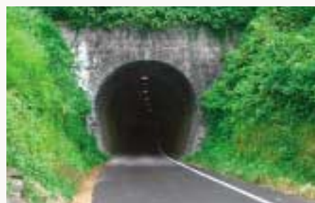
千々石第3隧道(1927年(昭和2)建設、旧小浜鉄道・廃線)
