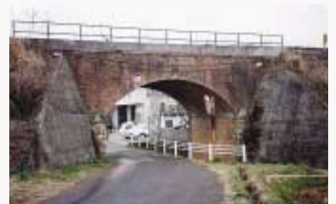
的場橋(1898年(明治31)建設)
