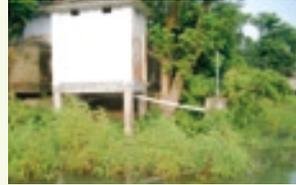
排泄物による川や池などの汚染対策として設けられたピットラトリン(簡易トイレ)。小屋の中にトイレがあり、排泄物はパイプでつながったピットラトリンという容器に貯められる。容器がいっぱいになったら新しい容器に替える。貯まった容器は蓋をして、感染症の原因になるバクテリアが分解されるのを待つ。
