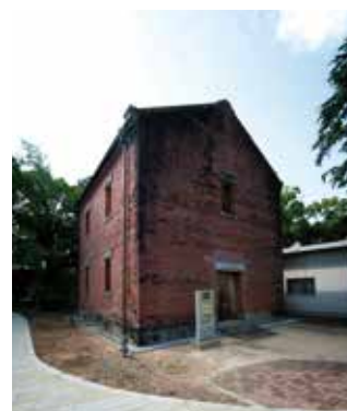
レンガ倉庫（明治40年2月竣工）
