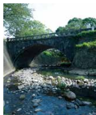
拱橋（明治36年11月架橋）
