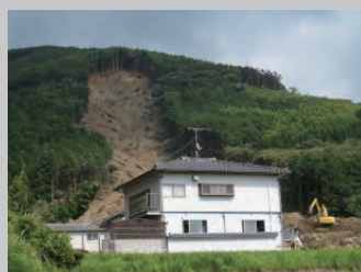
豪雨に起因した斜面災害
